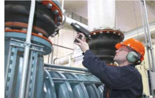
Pruebas con tecnología ultrasónica pueden utilizarse también para complementar los análisis de vibración y termografía infrarroja
